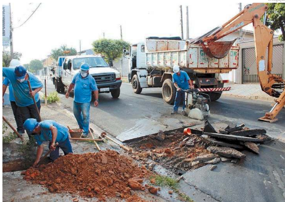
MÃO DE OBRA | Trabalhadores realizam serviço de manutenção em rede de água
