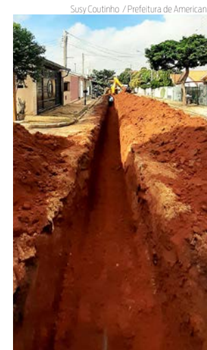
OBRAS | Na Vila Belvedere
