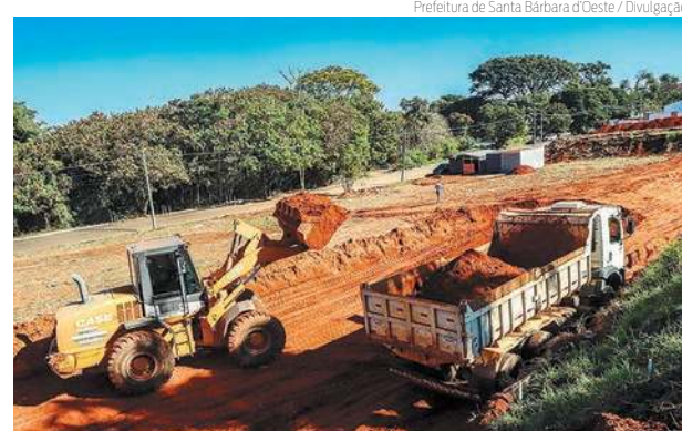
OBRAS | Terraplanagem começou na área em S. Bárbara
