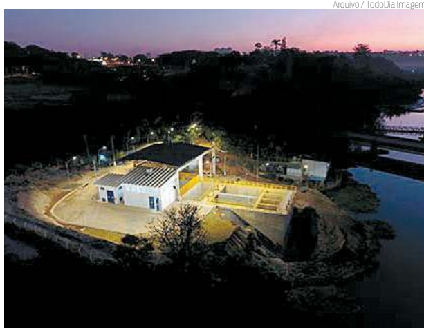
CAPTAÇÃO | Falha no sistema do Rio Piracicaba ontem
