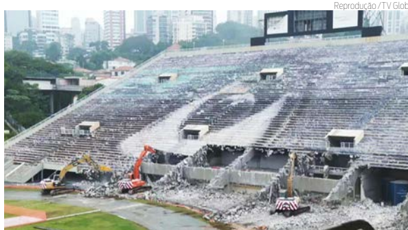
MODERNIZAÇÃO | Tobogã começou a ser demolido
