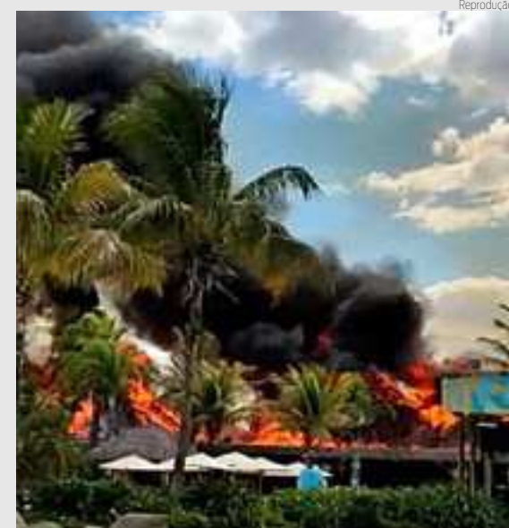
FOGO | Estruturas do resort ficaram destruídas
