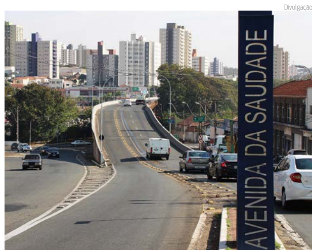
VIADUTO | Fechado das 22h de quinta às 5h de sexta
