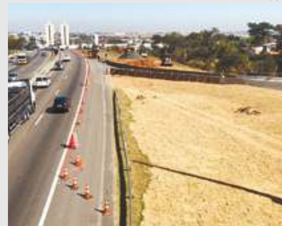
OBRAS | Alça de acesso na SP-101 segue avançando
