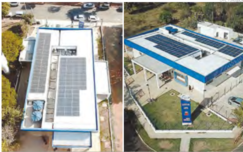
PAINÉIS FOTOVOLTAICOS | PA do Zanaga (esq.) e UBS do Boer estão no programa
