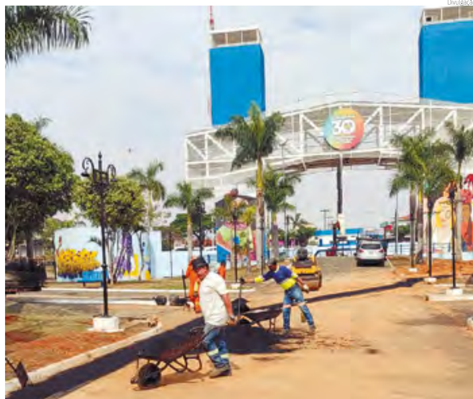
QUASE LÁ | Operários trabalham na fase final do processo de revitalização da praça “A Poderosa”, umas principais áreas de lazer de Hortolândia.
