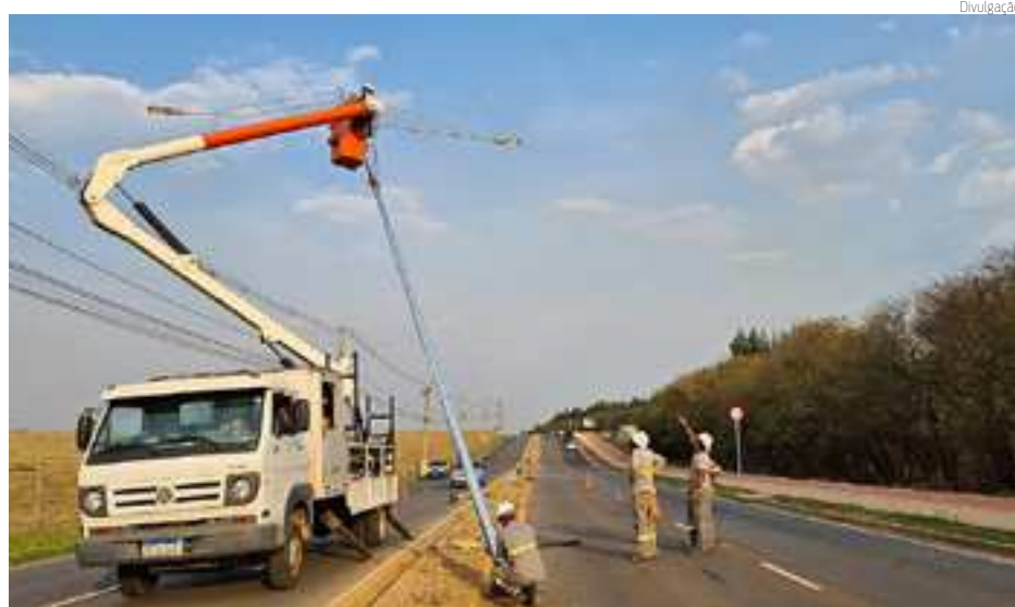
ILUMINAÇÃO | Postes sendo instalados na Avenida Ana Thereza Cecon Breda
