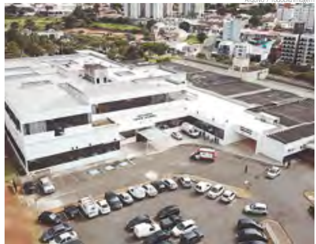
HOSPITAL MUNICIPAL | Novas obras sendo iniciadas
