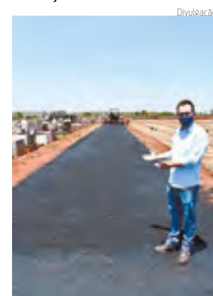
ASFALTO | Dalben vistoria
