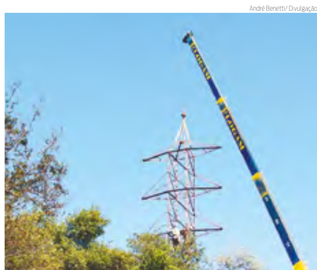
RETIRADA | Guincho trabalha na remoção da velha torre
