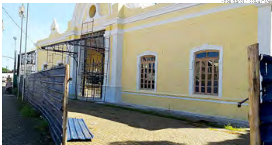
SÓ TAPUME E ANDAIME | Restauro na Estação Cultura começou em janeiro de 2020
