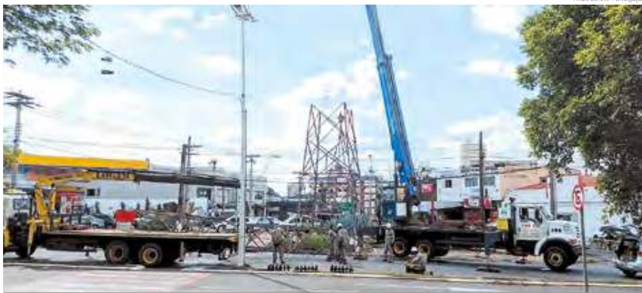
REMOÇÃO DAS TORRES | Trabalho na última sexta foi executado na Avenida Florindo Cibin com Avenida de Cillo
