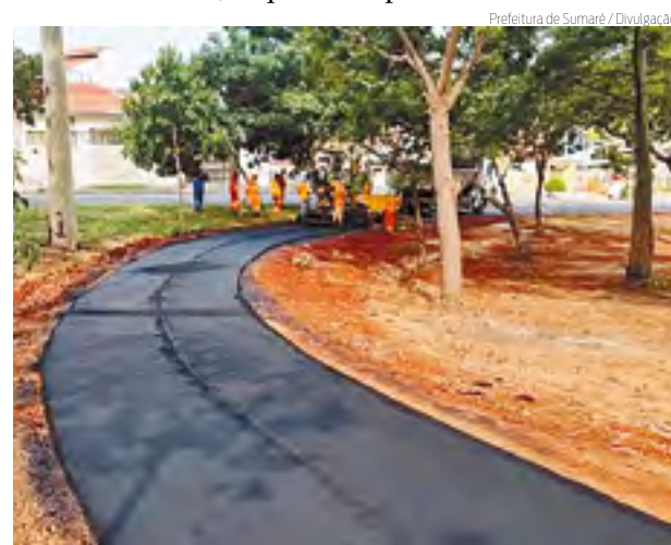
PRAÇA | Obras estão transformando espaço em Sumaré
