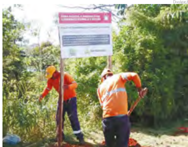
ALERTA | Placas com avisos estão sendo instaladas
