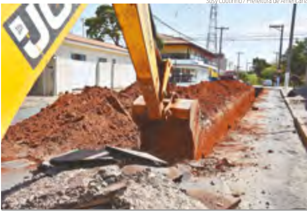
DAE | Redes antigas vêm sendo substituídas na cidade
