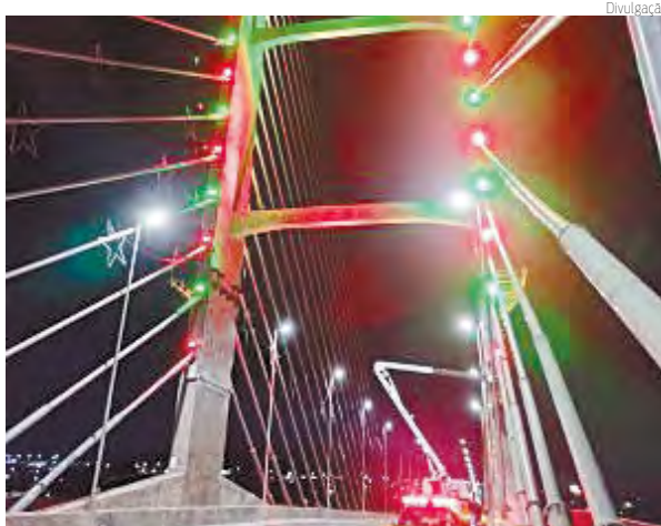
LUZES | Ponte Estaiada acende iluminação especial
