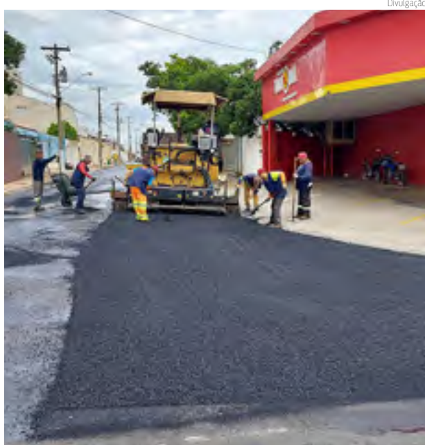
RECAPEAMENTO | Iniciado em vias do São Domingos
