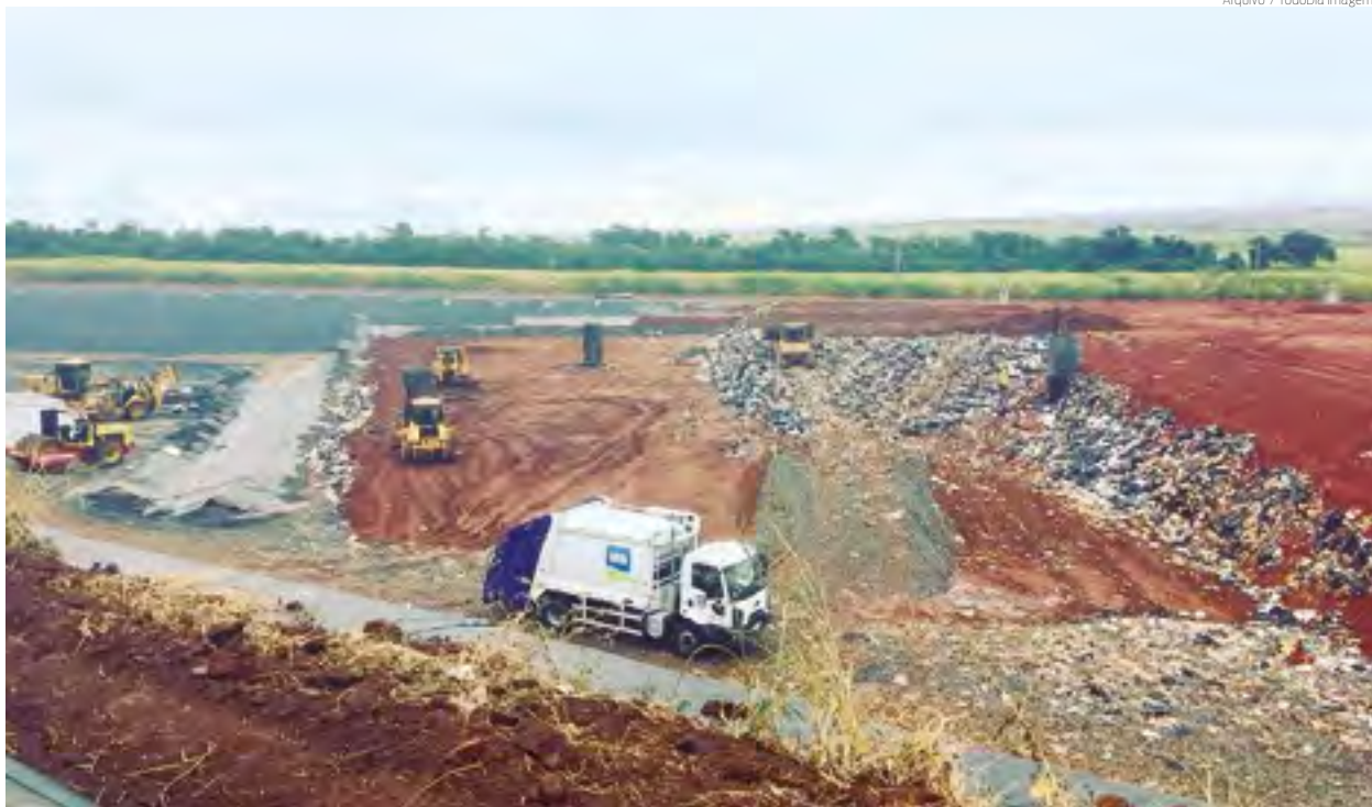
ATERRO SANITÁRIO | Proposta do Consórcio Intermunicipal de Manejo de Resíduos é eliminar depósitos de lixo
