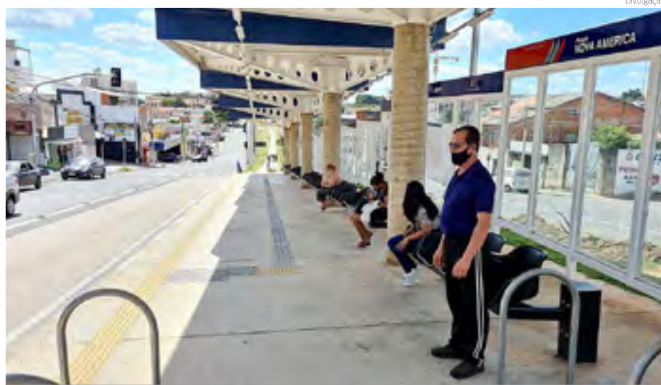
CORREDOR METROPOLITANO | Trecho final, em Hortolândia, movimentando a região
