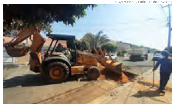
REPARO | DAE conserta vazamento no Morada do Sol
