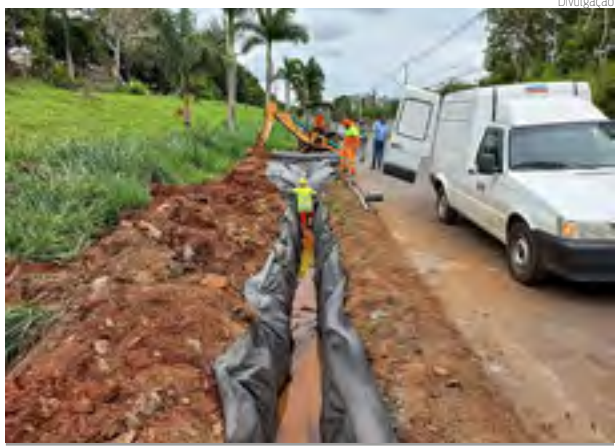
OBRA | Iniciada pela drenagem no trecho de Americana
