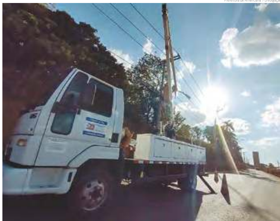
ENERGIA | Troca de lâmpadas de vapor de sódio por luzes de LED amplia economia
