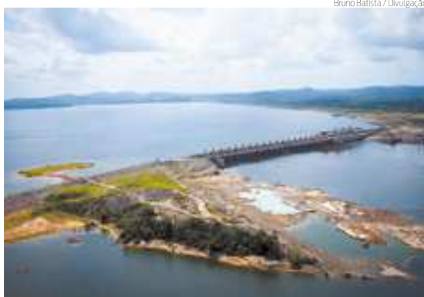
CAPACIDADE | Reservatórios aumentaram volume
