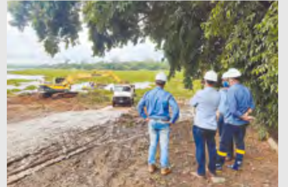
VISTORIA | Retirada de aguapés segue na represa
