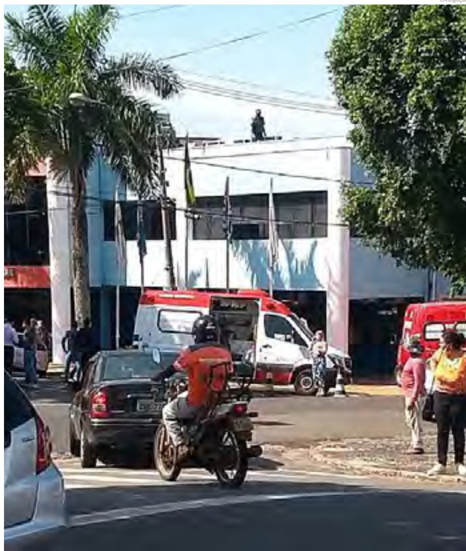
CÂMARA | Bombeiro no telhado, onde trabalhador de 41 anos morreu em Sumaré
