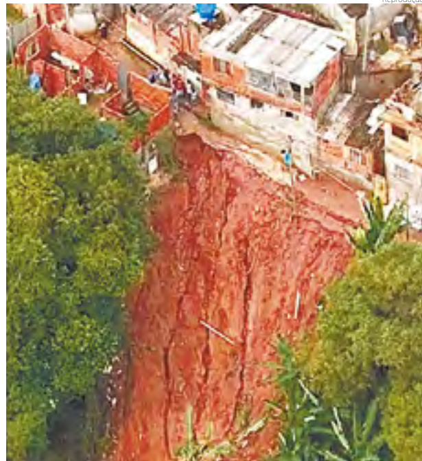
RISCO | Deslizamento de terra em Embu das Artes
