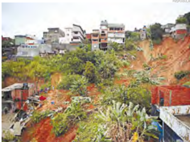
MORTE | Deslizamento em área de Franco da Rocha
