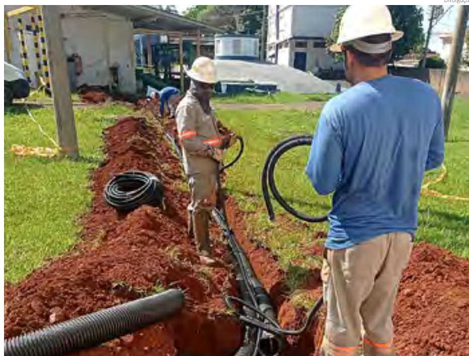
OBRA | Instalação de motobomba na ETA é prevista para terminar em até oito semanas
