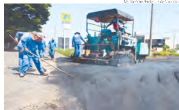
ASFALTO | Trecho da Av. do Compositor em obras ontem
