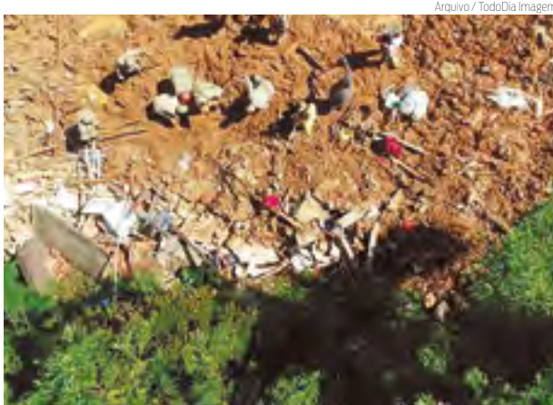
MORTES | Deslizamento em Petrópolis após chuvas
