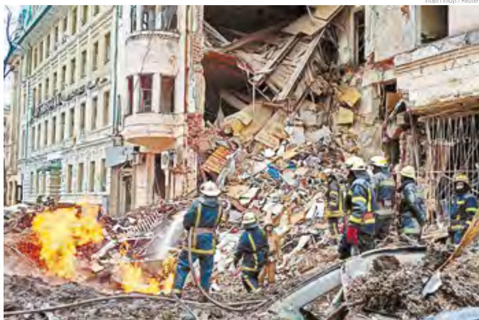
ATAQUE | Prédio residencial na Ucrânia destruído parcialmente após bombardeio russo
