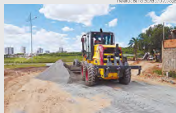
VIÁRIO DO LAGO DA FÉ | Obras foram iniciadas
