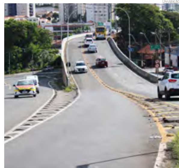
VIADUTO | Ficará Fechado de 7h às 17h no domingo
