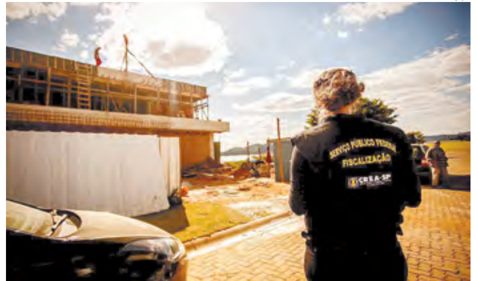
FISCALIZAÇÃO | Força-tarefa do CreaSP vai percorrer obras em 18 cidades da região
