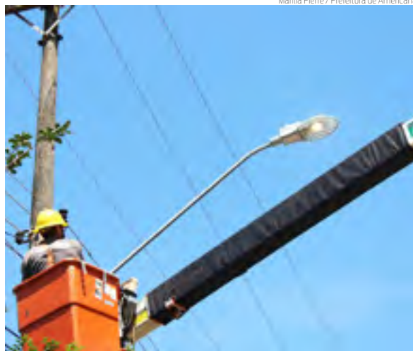
TROCA NA ILUMINAÇÃO | Instalação de LED avança
