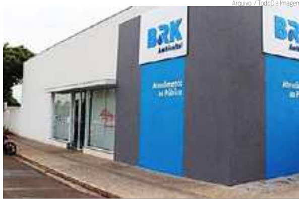
BRK AMBIENTAL | Condenada por vazamento
