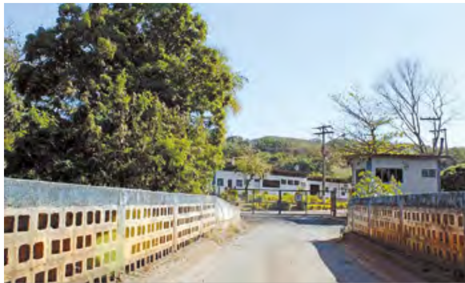
ESTAÇÃO DE TRATAMENTO DE ESGOTO CARIOBA | Impasse para início das obras
