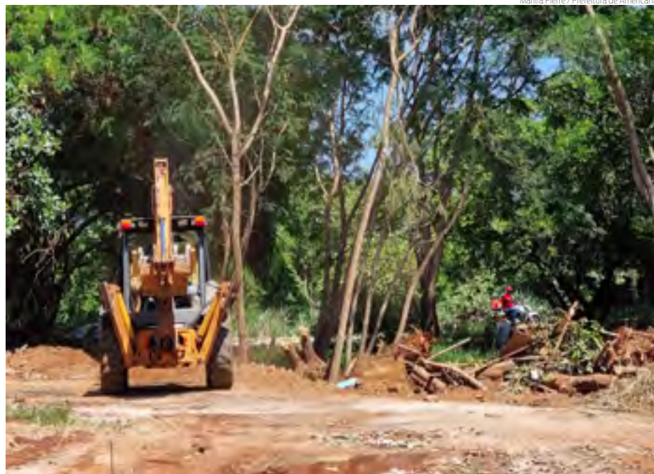
OBRA | Serviços começaram com retirada de mato e terraplanagem na Rua Noruega
