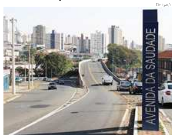
OBRA | Viaduto Ralph Biasi irá precisar de manutenção
