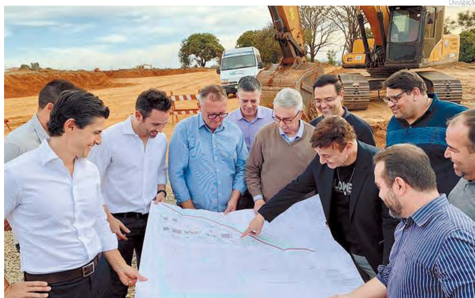
TERRENO | Área passa por serviços de terraplanagem e previsão é inaugurar em 2024
