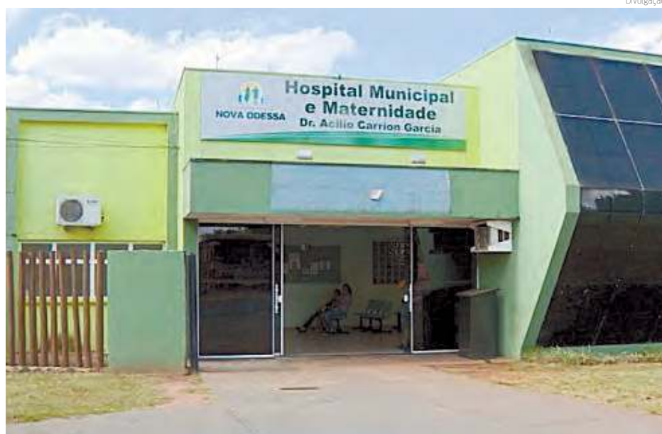
MÁS CONDIÇÕES | Hospital Municipal de Nova Odessa é alvo de apuração do MPT
