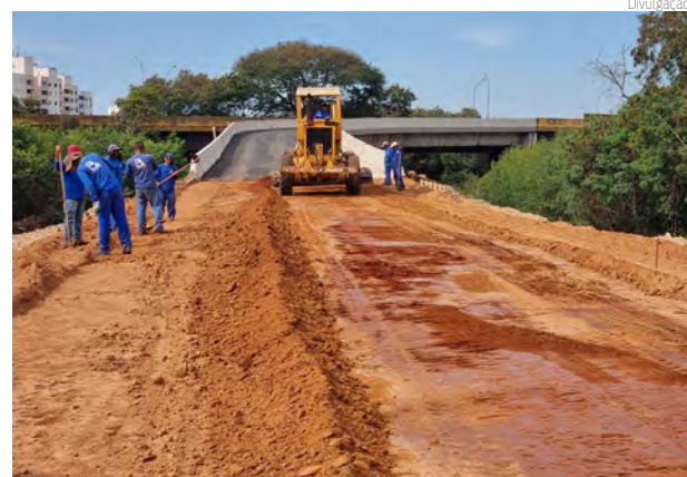
VIADUTO | Serviço de terraplanagem é realizado
