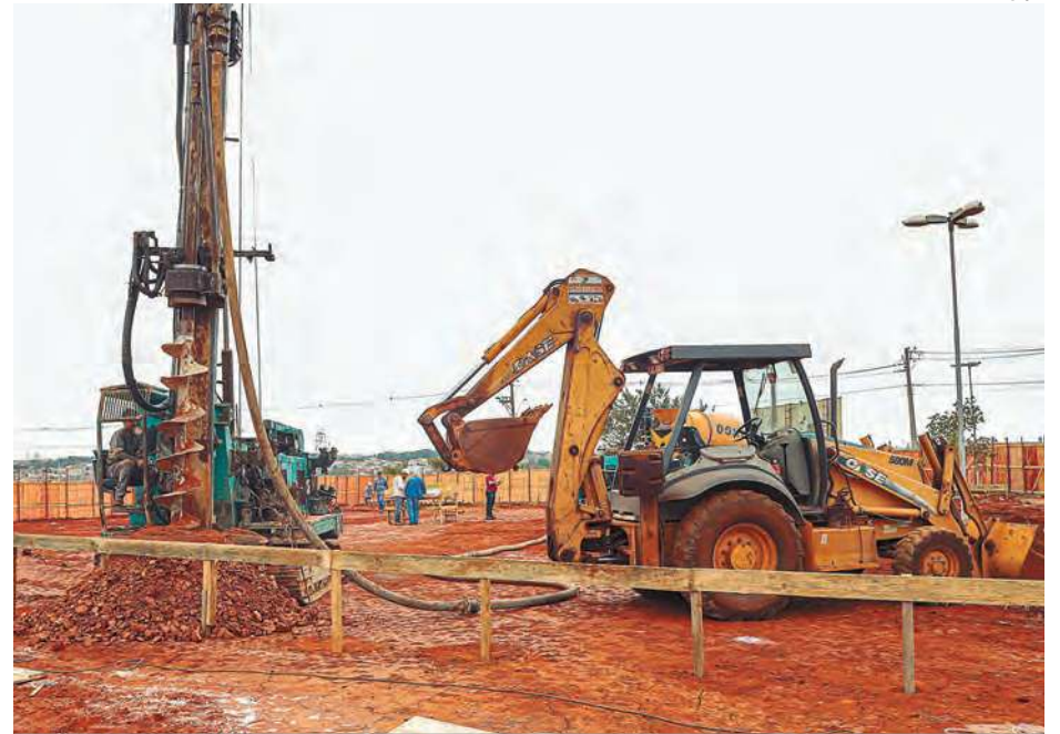
INÍCIO DAS OBRAS | Prédio da saúde terá 3,6 mil metros quadrados de construção
