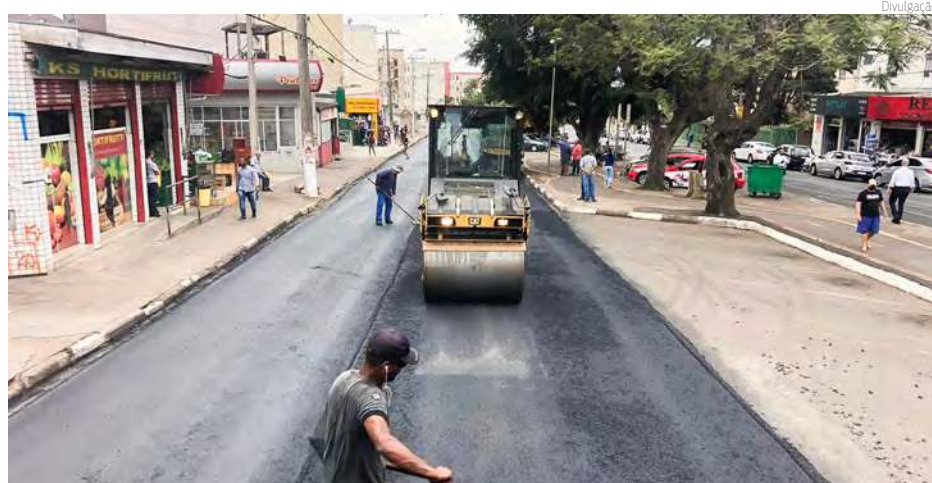
ASFALTO NOVO | A Secretaria de Serviços Públicos de Campinas está realizando obras de recapeamento na Avenida Papa João Paulo II, no Padre Anchieta.
