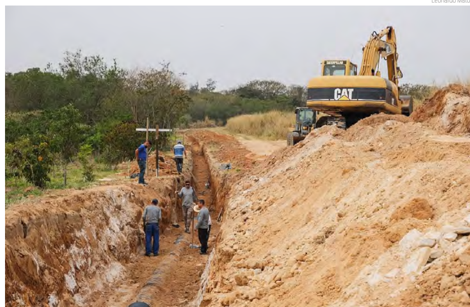
ESGOTO | Obras atenderão 40 mil pessoas em seis bairros no entorno da Gruta Dainese
