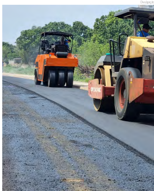
OBRA | Prolongamento é da Bandeirantes até viaduto
