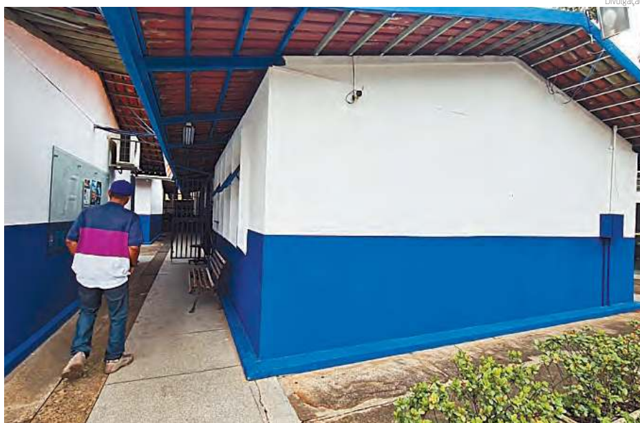
VIGILÂNCIA 24H | São 60 escolas municipais que terão equipamentos instalados
