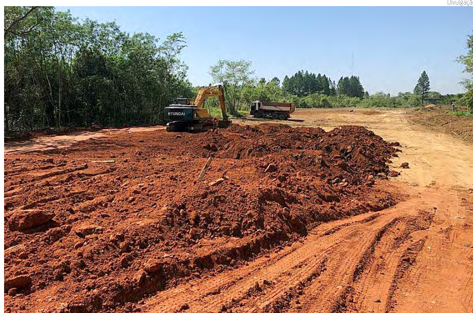
SUMARÉ | Obras de viaduto em andamento em Sumaré; prefeito diz que obra continua
